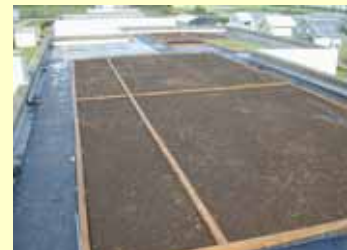
吹き付け植栽直後
