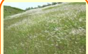
道路法面、河川堤防
