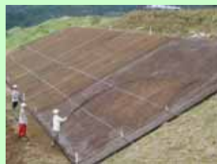
吹き付け植栽
