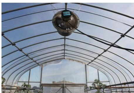
傾斜の高い側に、外向きに循環扇を設置することで、より排気を促します
