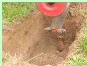
排水口に水が流れるようにサブソイラ施工のスジに交差するよう弾丸暗きよを入れる
