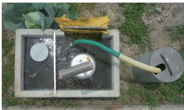
FOEAS柵 左:地下給水孔 中央:給水バルブ(水田時) 右:水位管理者
