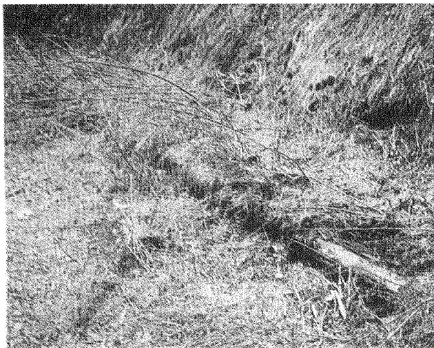
写真-2 雪の滑落により倒壊した柵工
