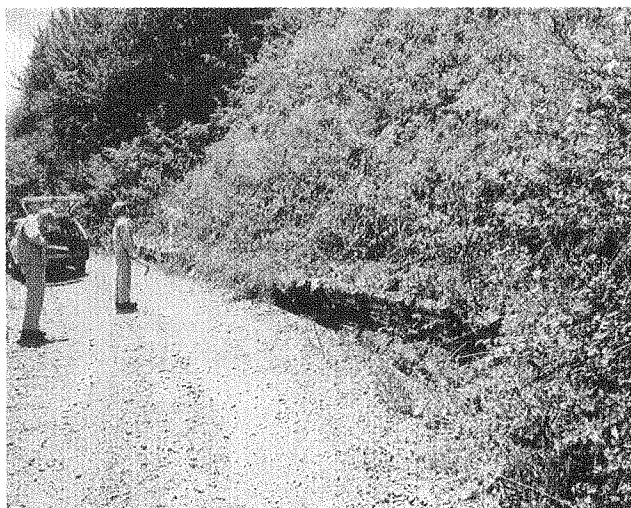
写真-3 杭の頭部が出すぎて倒壊した柵工
