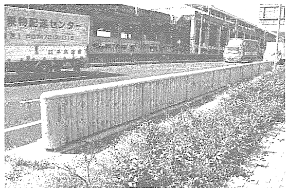
写真1 木製低層遮音壁
