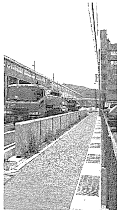
測定した遮音壁
