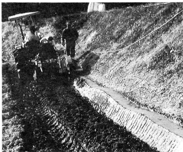
図2 第二工程 モルタル被覆の様子
