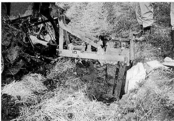
排水口から放射状に弾丸暗きょ設置
