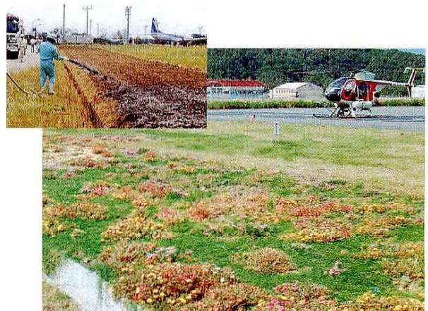
ピオセルショット工法による被覆植物の植え付け
