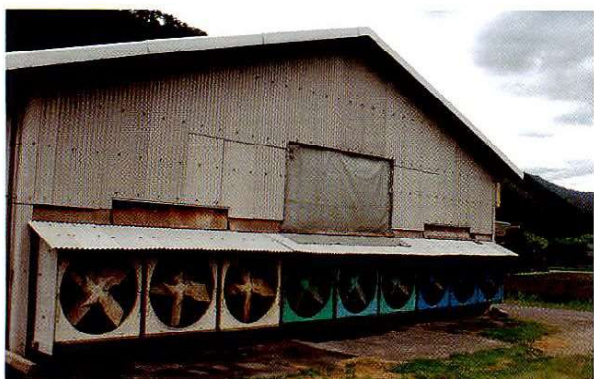
トンネル換気を導入した牛舎
