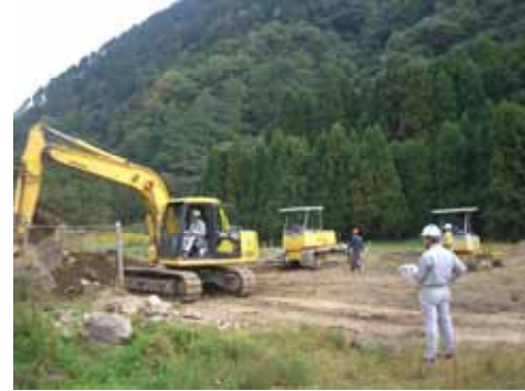
車両系建設機械運転技能講習
