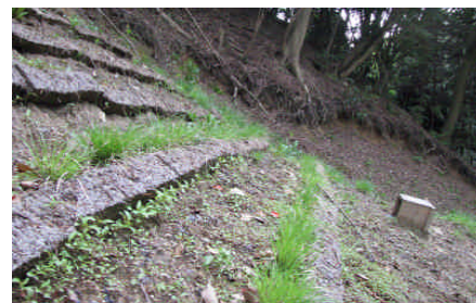
敷設状況(周囲で採取した植物を植栽)
