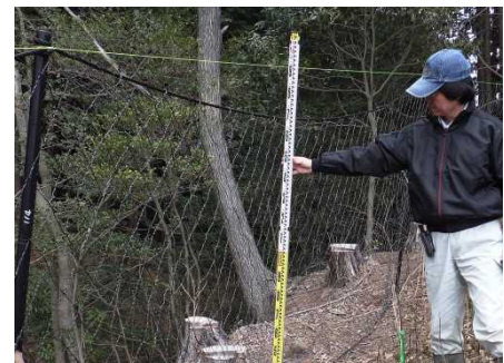
写真2 シカ防護柵ネットのたるみ
