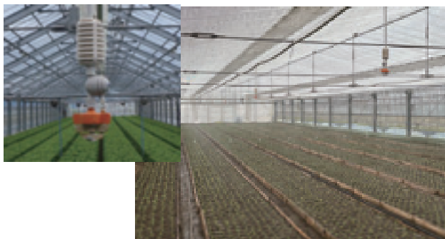
写真1 スプリンクラーの導入による頭上灌水
