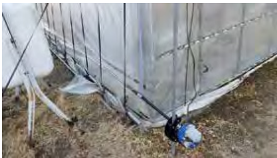
写真1 ハウスサイドの自動制御
