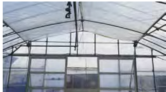
写真2 内張りの自動制御
